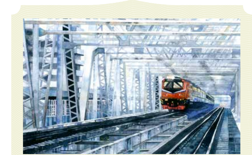
สะพานพระรามหก • ที่ตั้ง : แขวงบางซื่อ เขตบางซื่อ และแขวงบางอ้อ เขตบางพลัด กรุงเทพมหานคร • ลักษณะโครงสร้างสะพาน : สะพานโครงขึ้น(Through Truss Bridge) แบบคานยื่น รูปสี่เหลี่ยมคางหมู มี 5 ตอน มีตอม่อ 6 ตอม่อ ความสูงกว่าระดับน้ำทะเล 10 เมตร เรือสามารถแล่นลอดได้ สร้างโดยบริษัท 'Les Etablissements Dayde' แห่งประเทศฝรั่งเศส • ความยาว : 441.46 เมตร กว้าง 10 เมตร สร้างข้ามแม่น้ำเจ้าพระยา เชื่อมระหว่างเขตบางซื่อทางฝั่งตะวันออก กับเขตบางพลัดทางฝั่งตะวันตก • ปีที่สร้าง : พ.ศ.2465 - 2469
