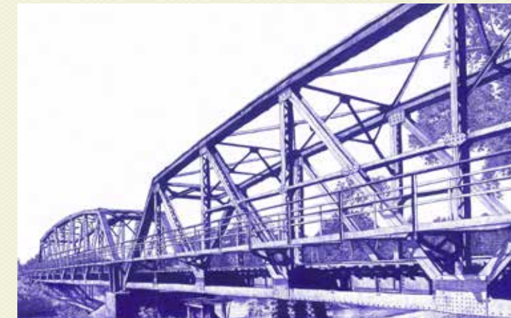
สะพานคลองจันดี หรือสะพานโครงรถไฟ 100 ปี
